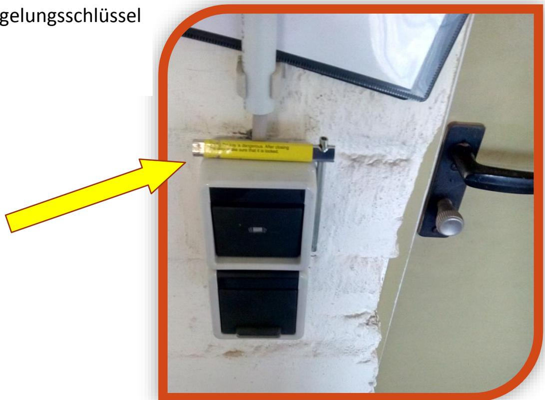
**6.** Standort des Fahrkorbes feststellen. Öffnen Sie die Schachttür, hinter der sich der Fahrkorb befindet – Wenn Sie feststellen, dass sich der Fahrkorb nicht dahinter befindet, schließen Sie diese sofort und vergewissern sich, dass diese verriegelt ist!
